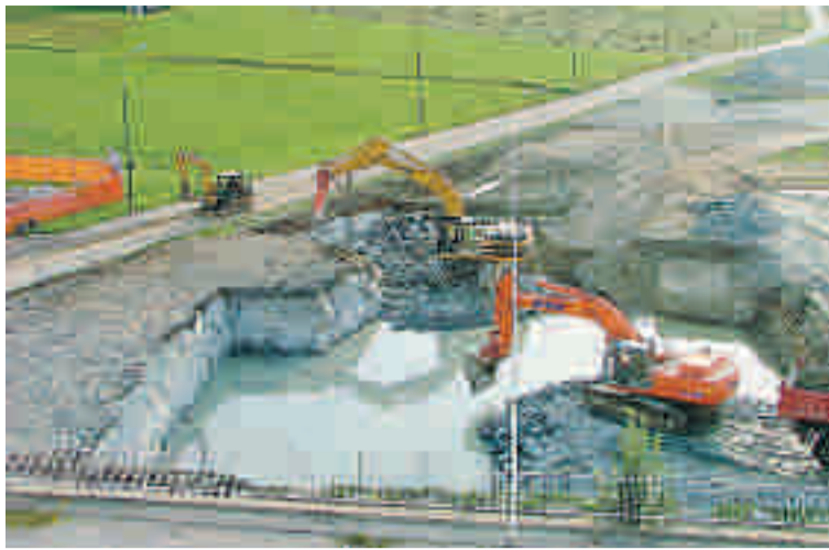
Scavi per nuova costruzione in zona San Pietro di Corteno Golgi
