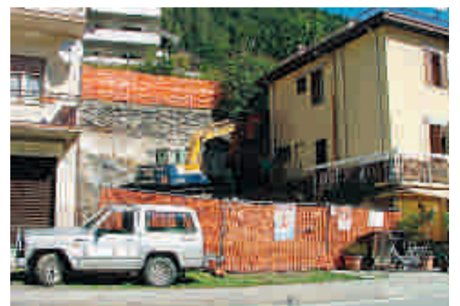
Scavi per nuovo box direttamente su Corso Roma, Aprica centro
