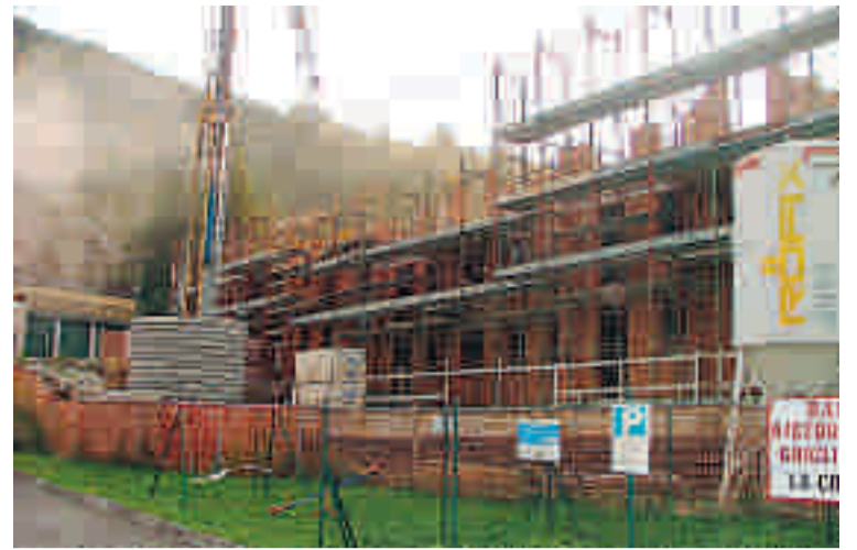
Condominio in fase di realizzazione in zona San Pietro di Corteno
