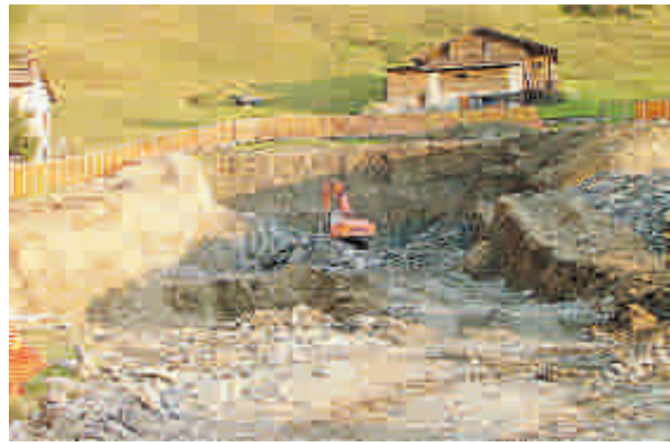
Scavi per costruzione a San Pietro di Corteno a fianco del ristorante Abete
